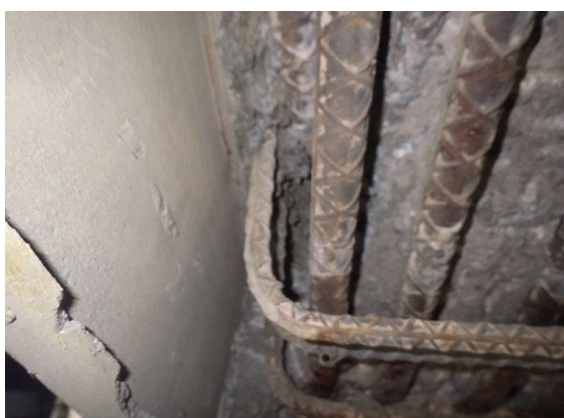
写真－5.1.24 側面吹付け後の主筋状況
