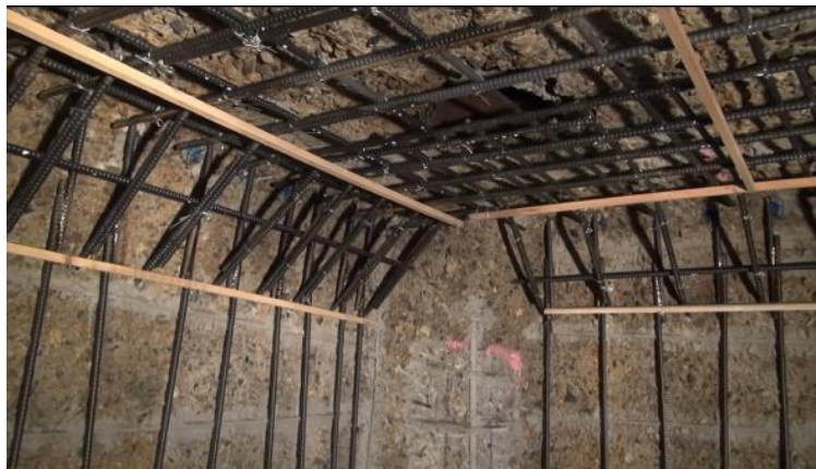
写真-5.2.2 補強鉄筋の設置状況
