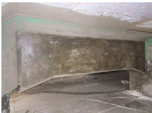
写真－5. 1. 26 側面仕上り状況
