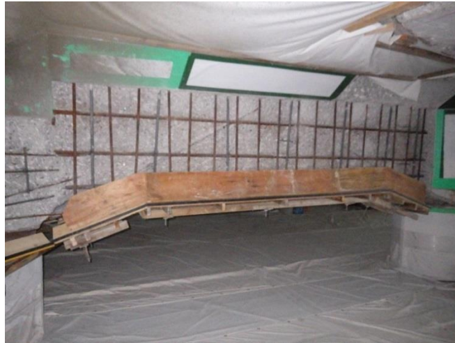
写真－5. 1. 20 考案した型枠の取付全景
