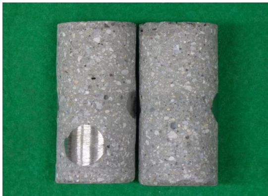
写真－5.1.8 上面吹付け鉄筋背面コア
