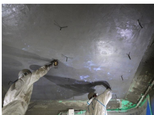
写真－5. 1. 31 スラブ面への仕上げ
