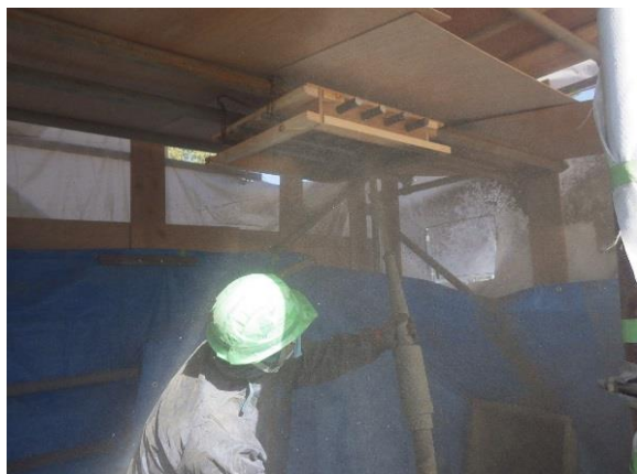
写真－5.1.4 上面吹付け状況
