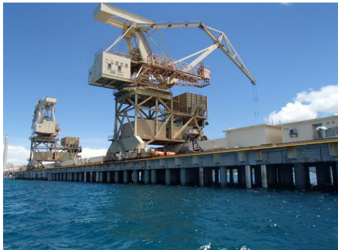
写真-5.1.1 揚炭栈橋全景
