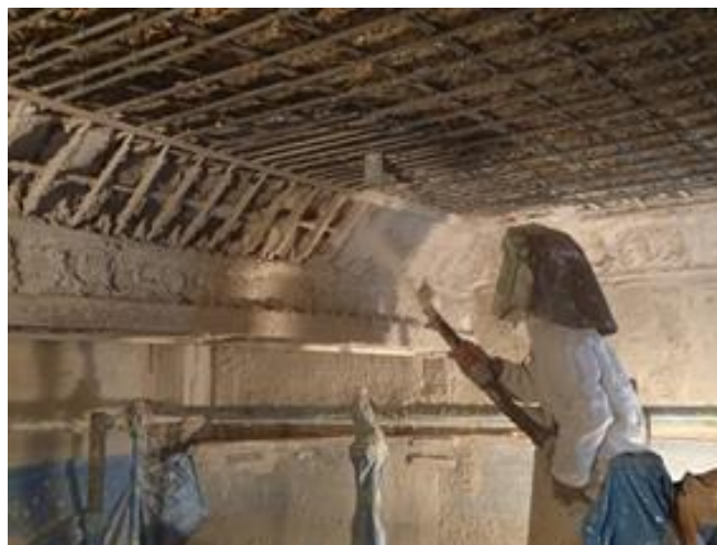
写真－5. 2. 5 乾式吹付け状況
