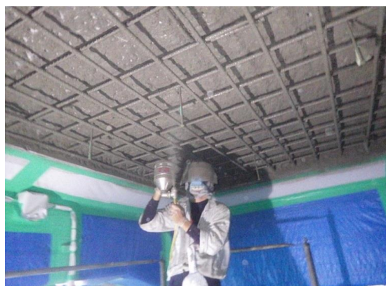
写真－5. 1. 29 亜硝酸リチウム入り セメントモルタルの塗布
