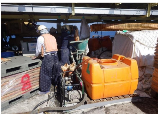
写真－5.1.19 プラント施工状況
