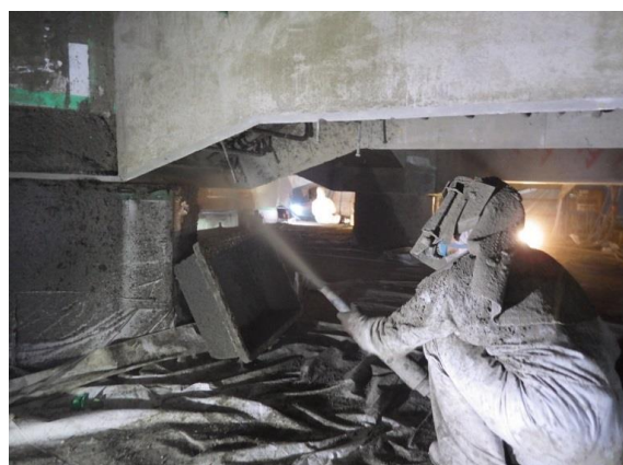
写真－5.1.25 梁下面の吹付け状況
