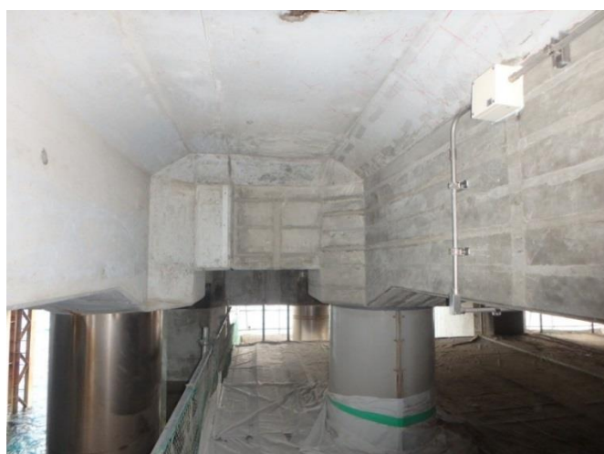
写真－5.1.34 電気防食工法完了後の全景
