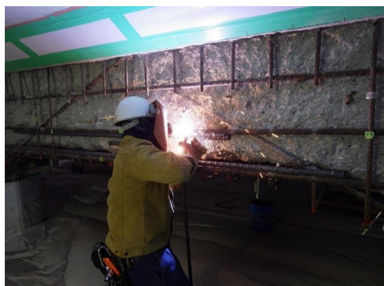
写真－5.1.16 溶接による鉄筋補強工
