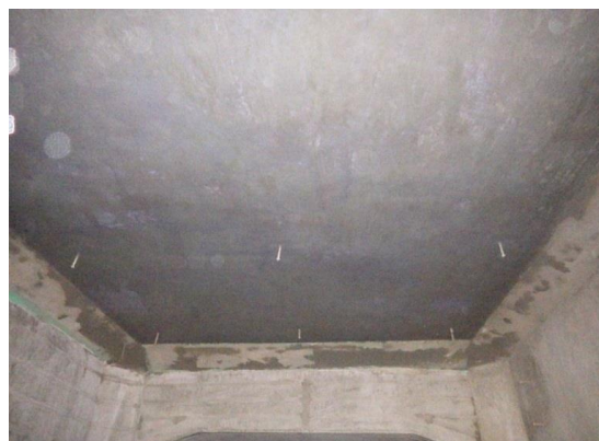
写真-5.1.32 スラブ面完了 2
