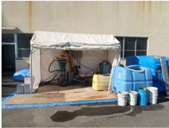
写真－5. 2. 3 乾式吹付けシステム（プラント）
