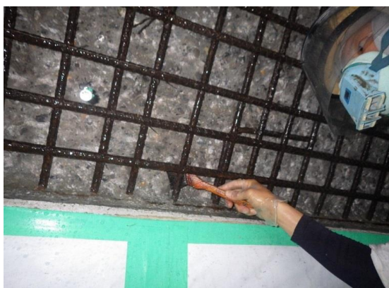
写真－5. 1. 28 亜硝酸リチウム防錆剤塗布
