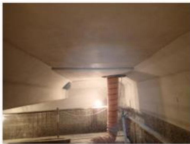
写真－5.2.4 補修完了状況
