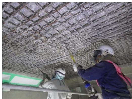
写真－5.1.13 スラブ免ハツリ状況
