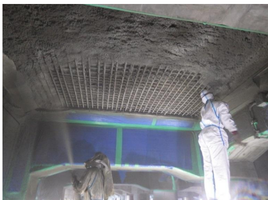
写真－5. 1. 30 スラブ面への吹付け
