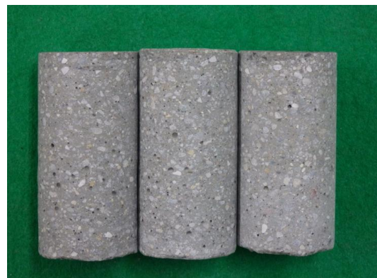
写真－5.1.11 側面吹付け無筋コア
