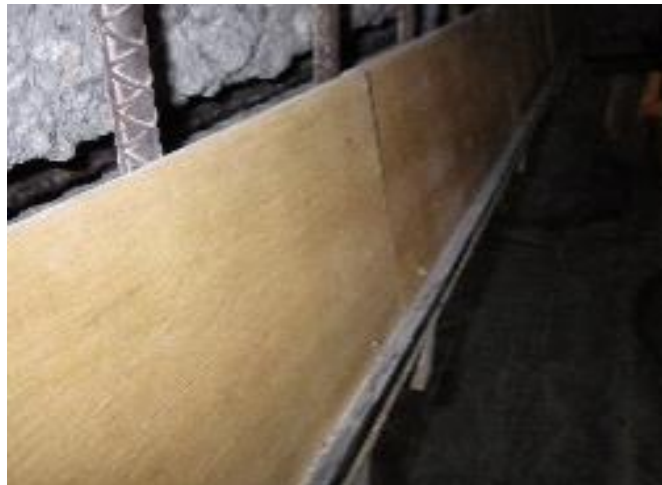
写真－5. 1. 21 考案した型枠の断面
