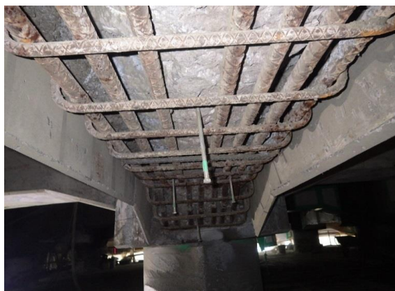
写真－5.1.23 梁側面型枠除去後の梁下面
