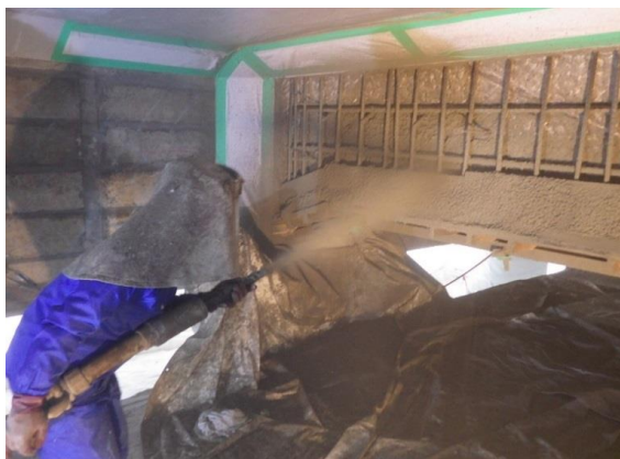
写真－5.1.22 梁側面の吹付け状況
