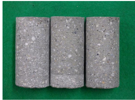
写真－5.1.9 上面吹付け無筋コア
