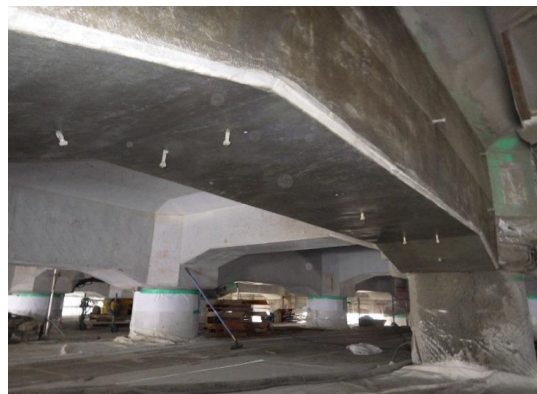
写真－5. 1. 26 梁下面仕上り状況
