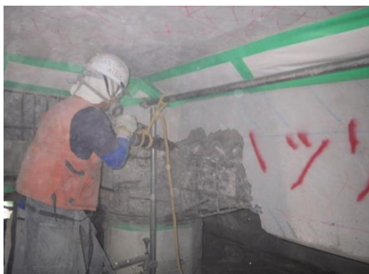
写真－5.1.12 梁部ハツリ状況
