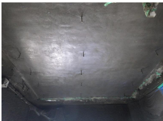
写真-5.1.32 スラブ面完了 1
