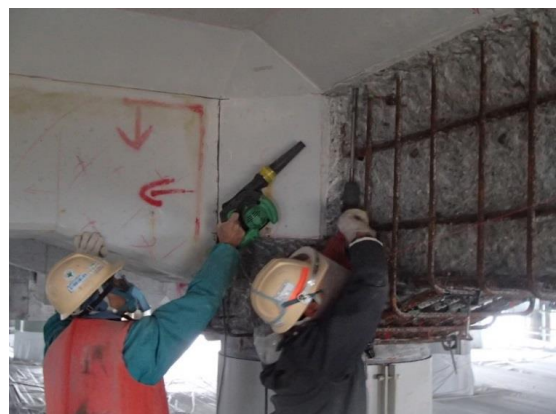
写真－5.1.17 あと施工アンカー鉄筋補強工
