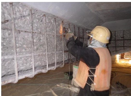
写真－5.1.14 サンダーによる鉄筋ケレン
